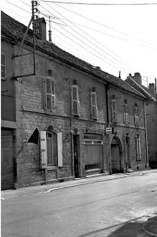
Façade antérieure en pierre de taille.
