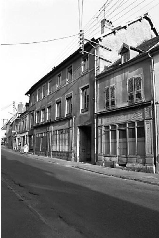
Façade antérieure avec magasins au rez-de-chaussée.
