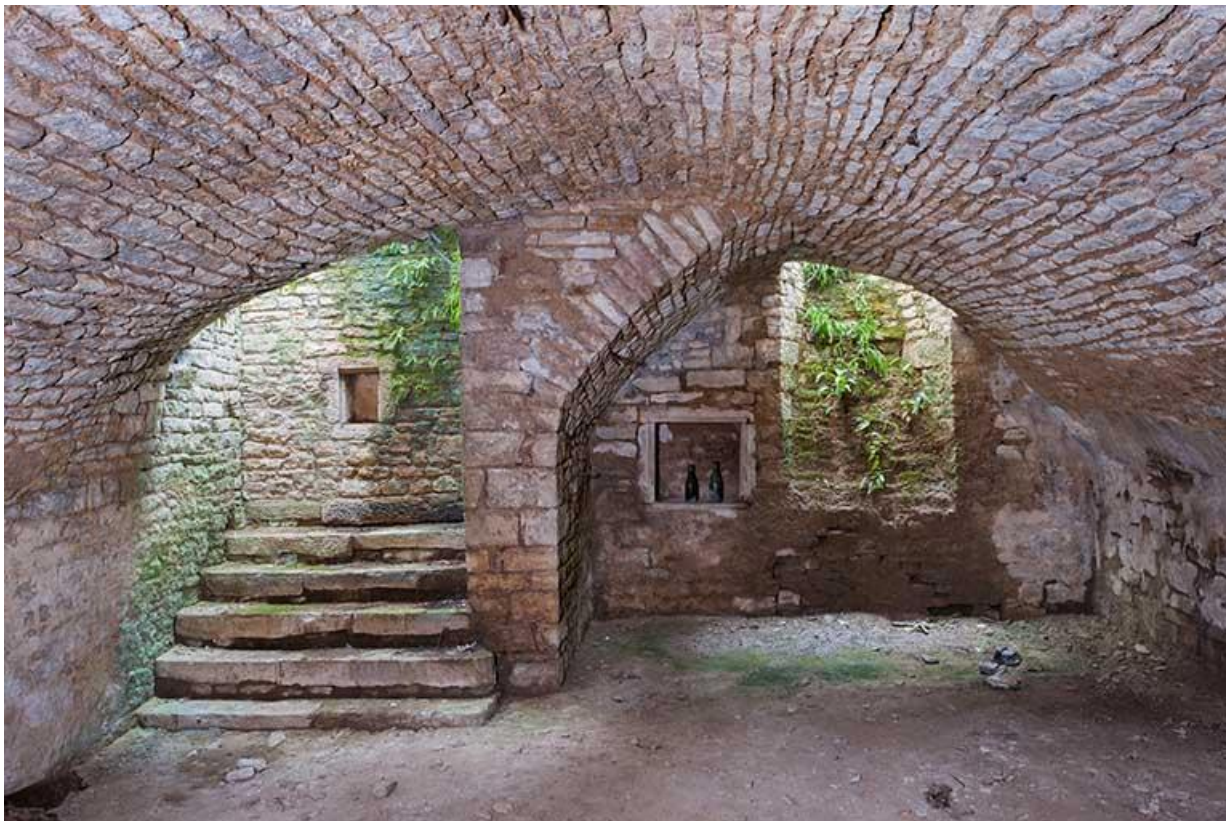
Vue générale de la cave
