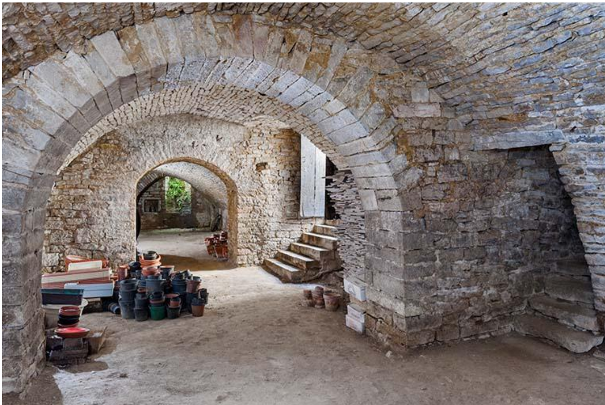
Vue générale de la cave
