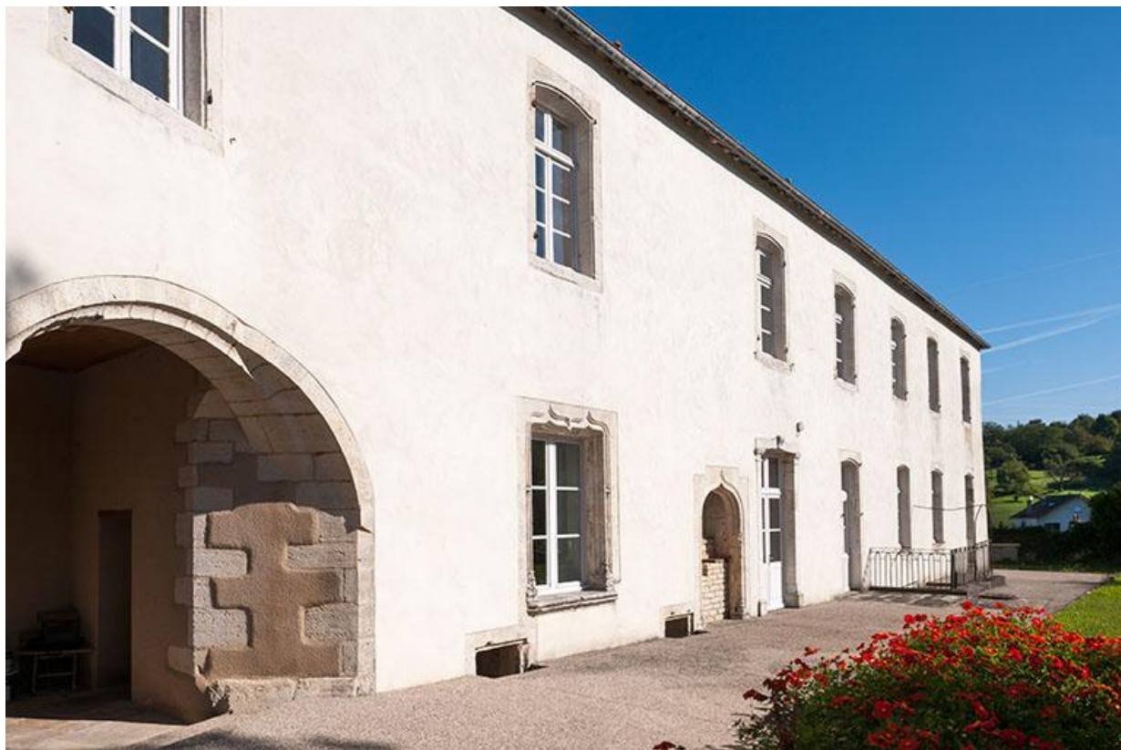
Vue sud-ouest du logis
