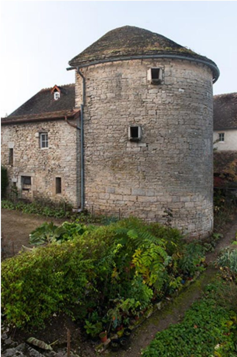
Tour de l'enceinte urbaine
