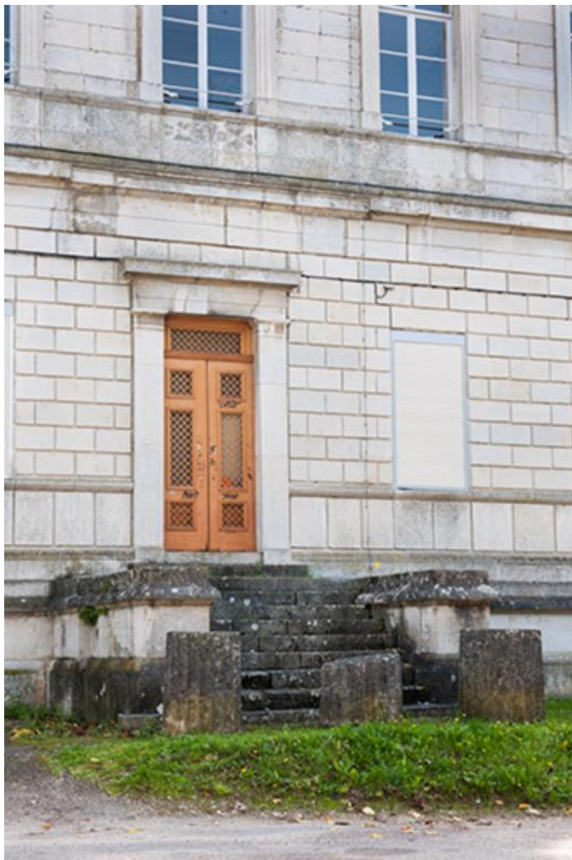
Porte de la façade nord
