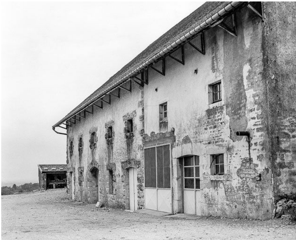
Partie agricole : façade postérieure.
