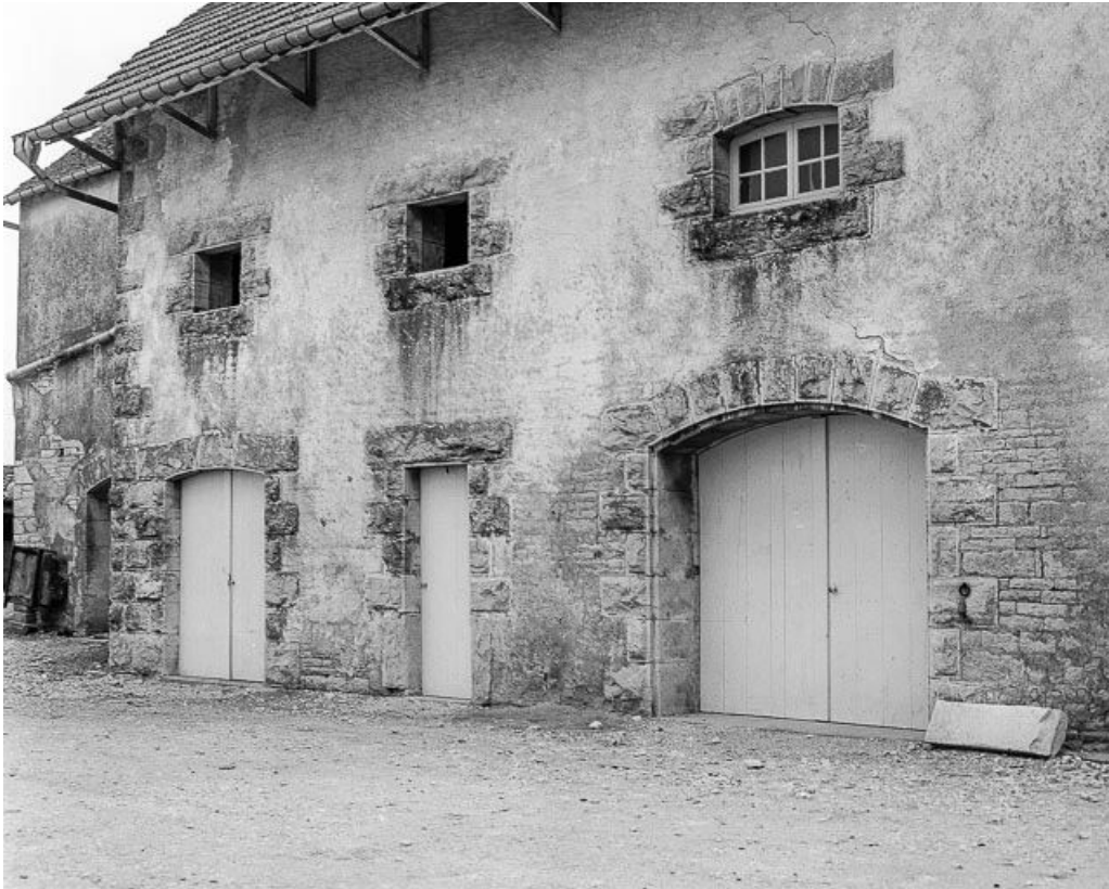
Partie agricole : détail de la façade postérieure.
