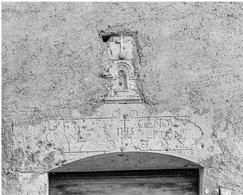
Détail de la porte d'habitation.
