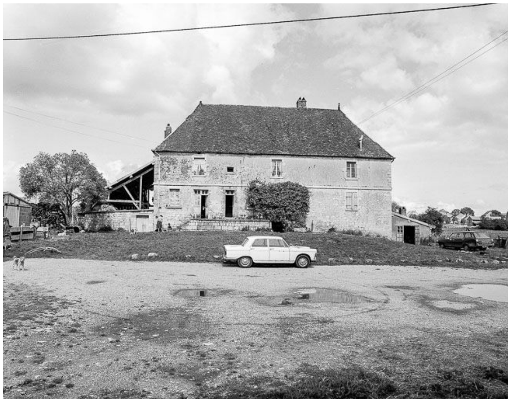
Partie habitation : vue de face.
