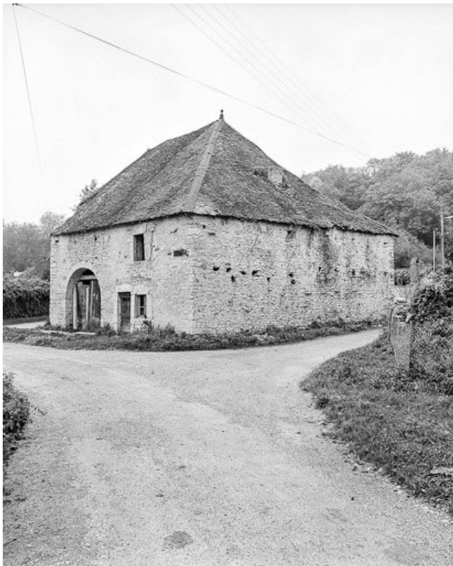
Façades antérieure et latérale droite.
