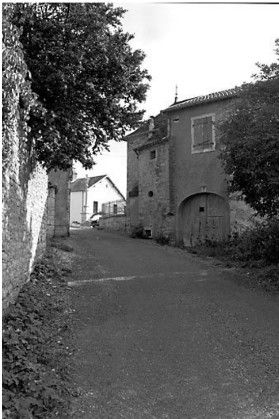
Façade latérale droite.
