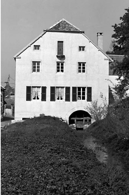
Façade latérale droite.
