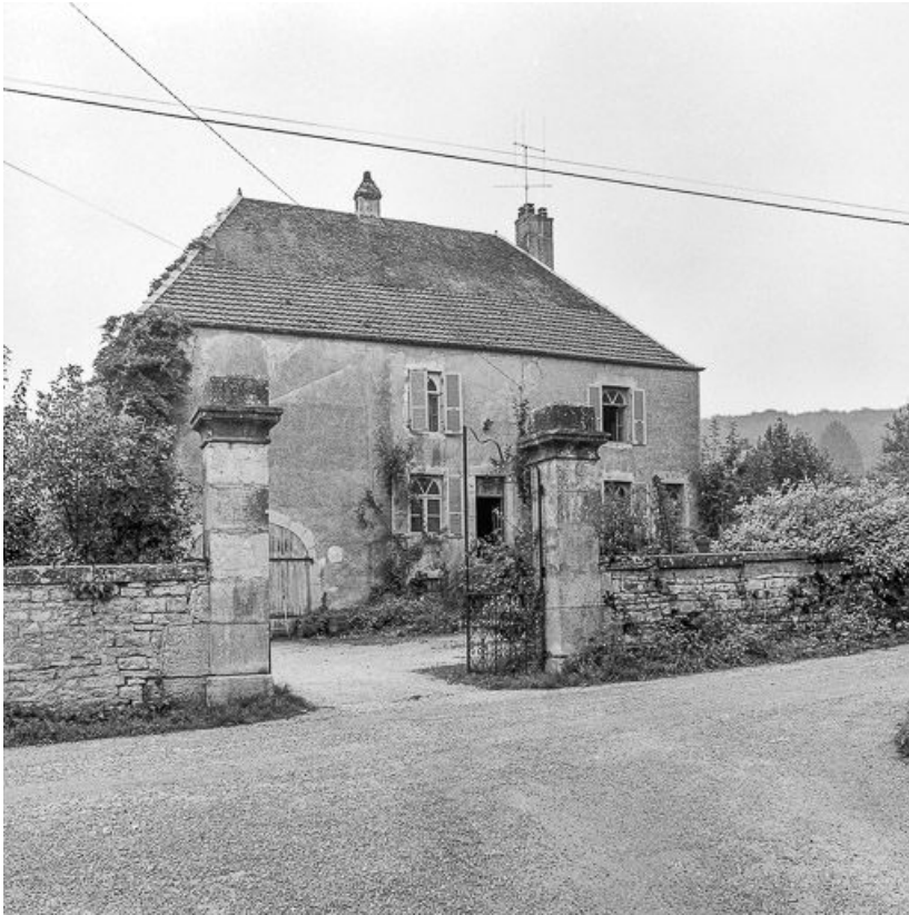
Vue de la partie habitation.
