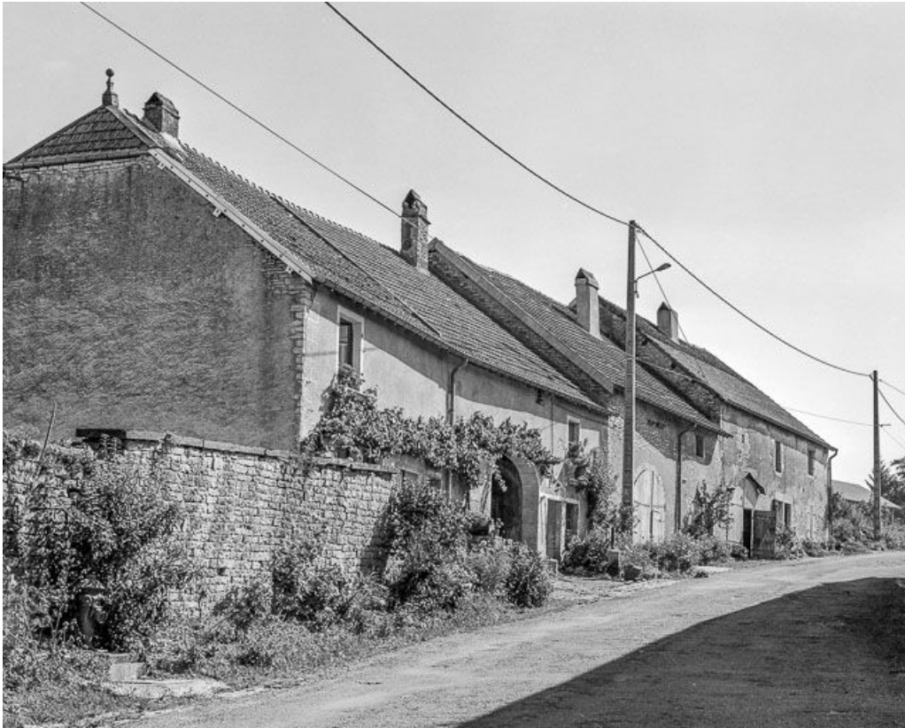
Vue d'ensemble, rue principale.
