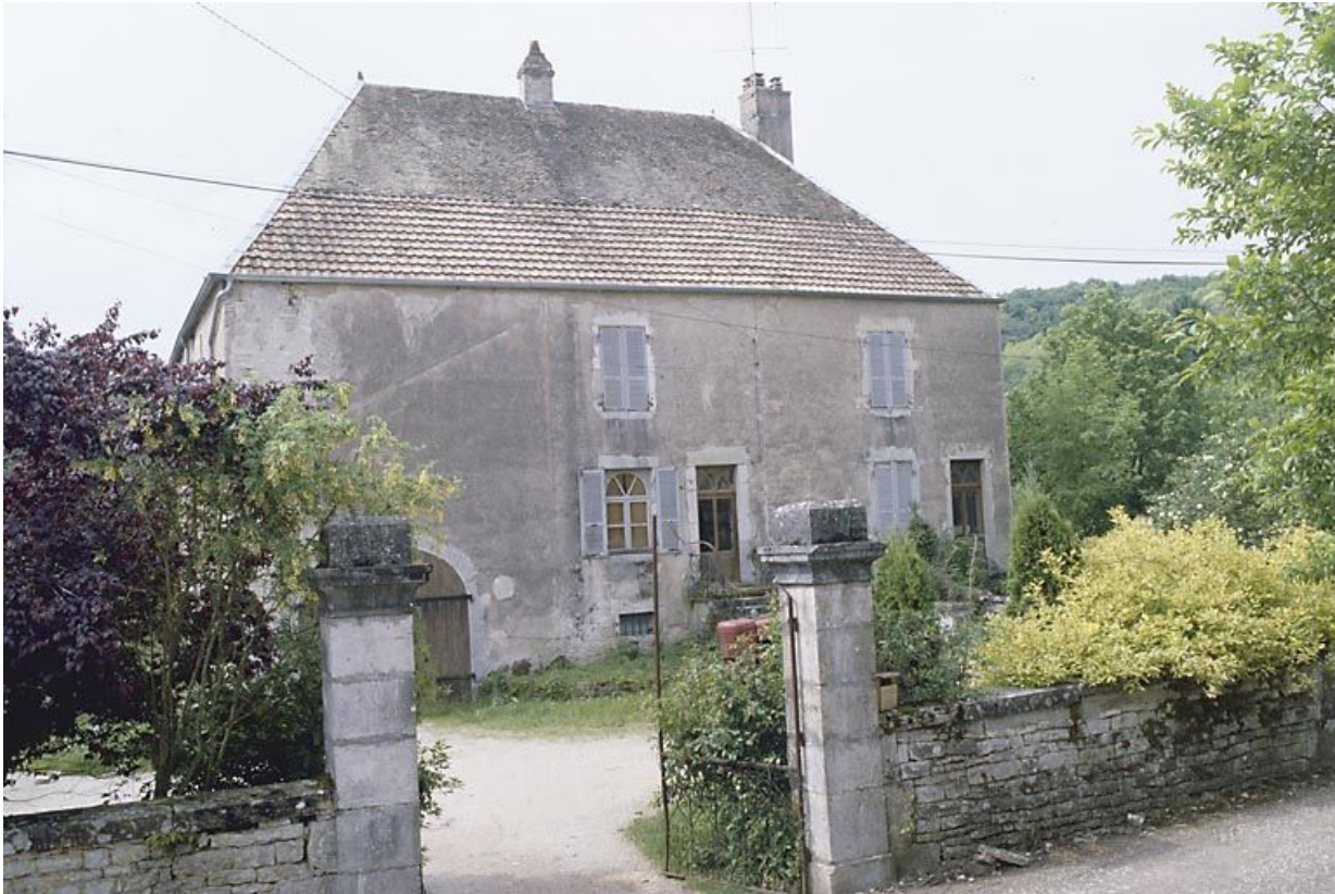
Façade antérieure de l'habitation.
