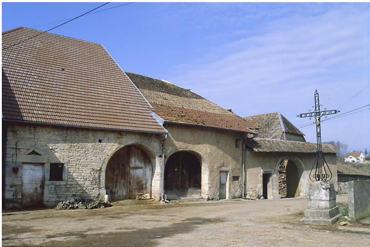
Vue d'ensemble depuis la rue.
