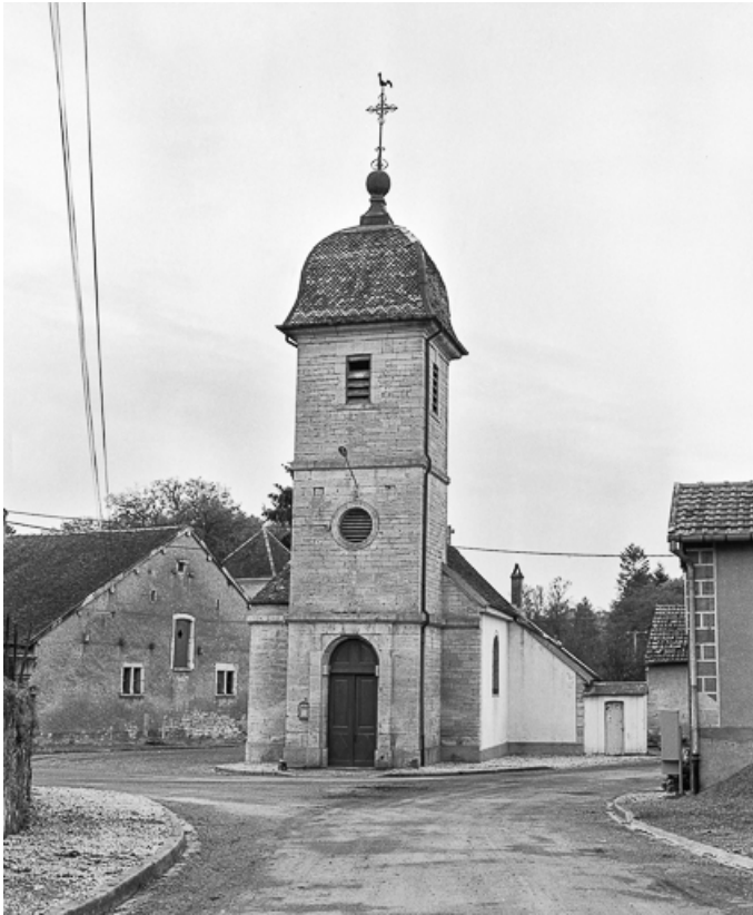
Extérieur : façade antérieure et clocher-porche.
