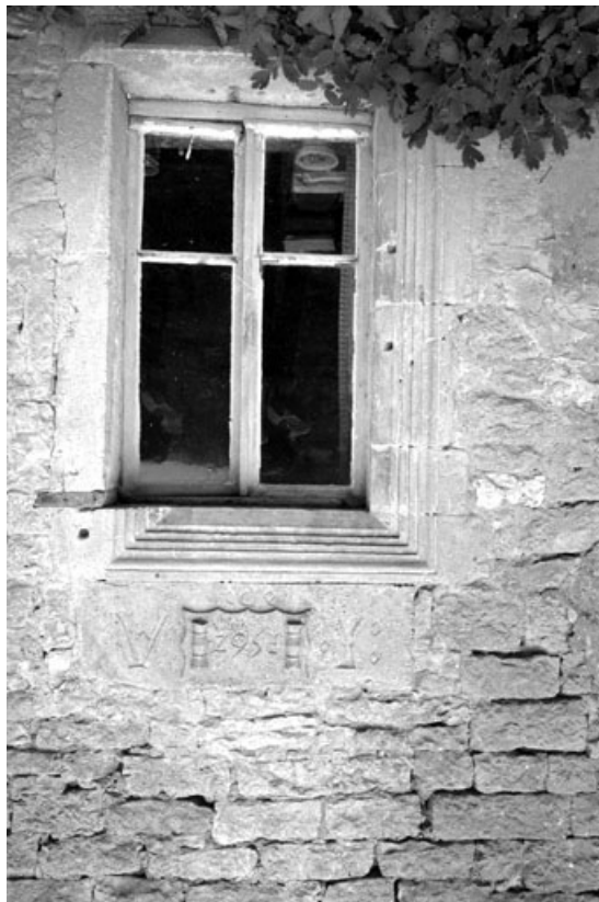
Détail de la façade postérieure.
