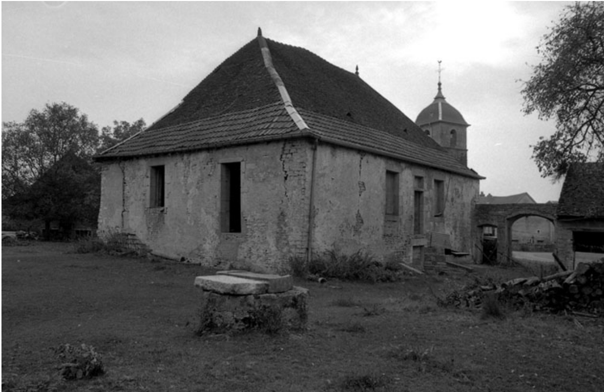
Façades antérieure et latérale gauche.
