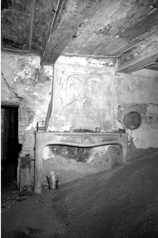
Vue intérieure : cheminée.
