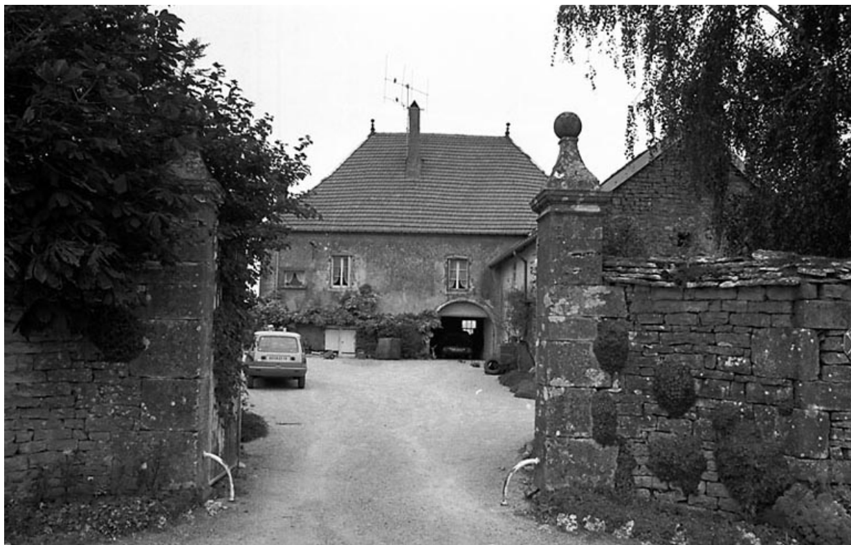
Vue de l'habitation.
