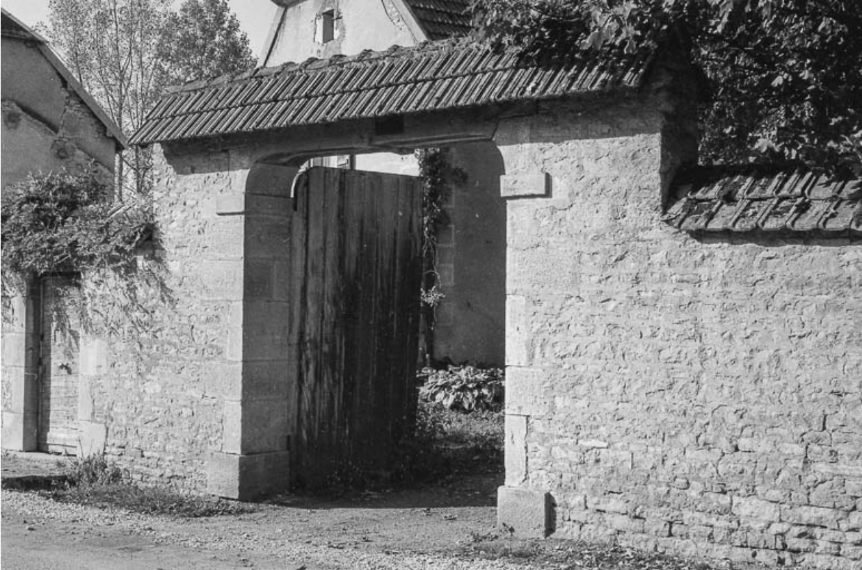
Détail : portail d'entrée.
