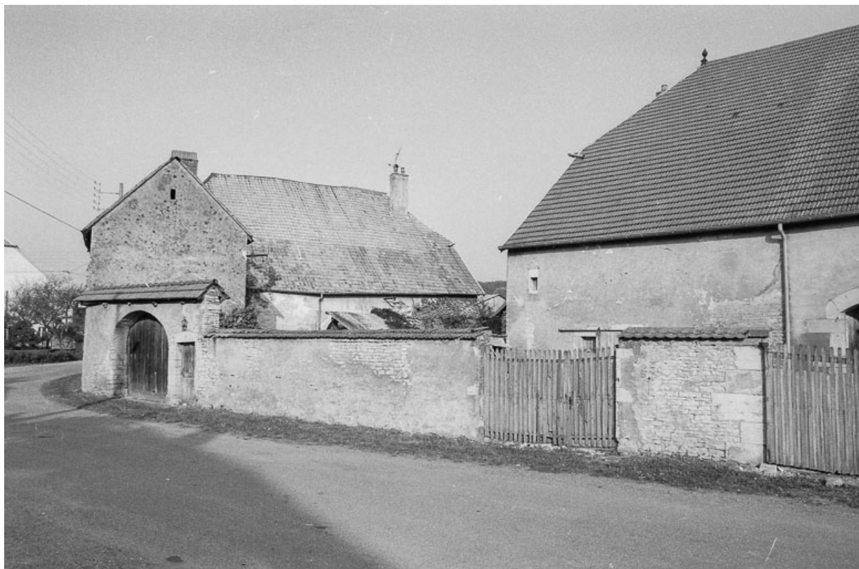
Façades sur rue.
