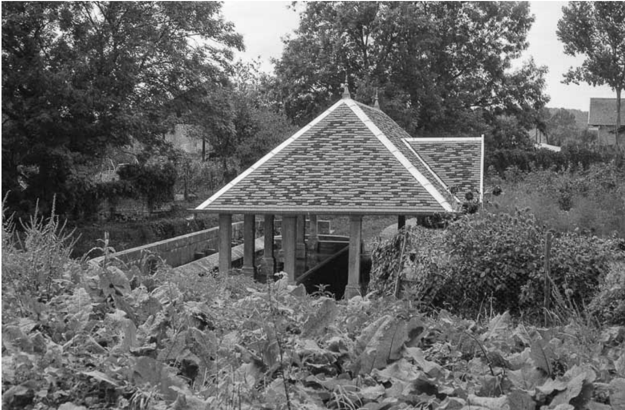
Façade latérale droite en 1979.
