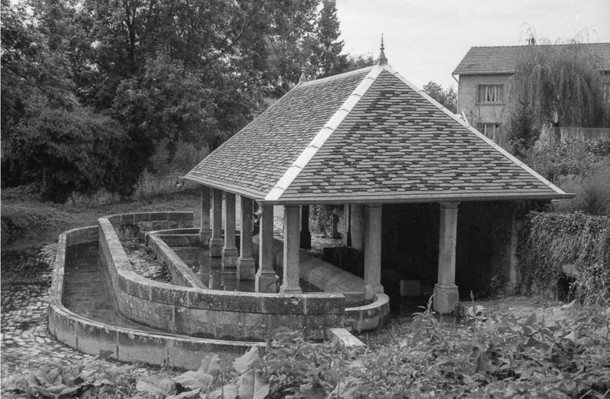
Façades antérieure et latérale droite en 1979. 70, Pin
