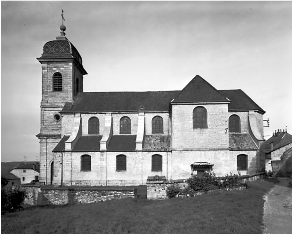
Façade latérale droite.
