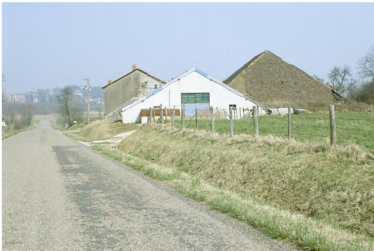
Vue d'ensemble depuis la route.
