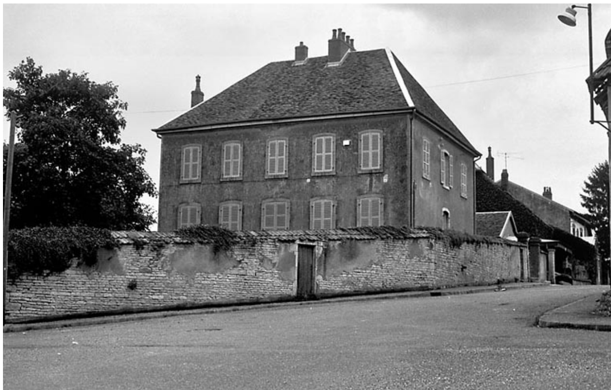
Vue d'ensemble depuis la rue.
