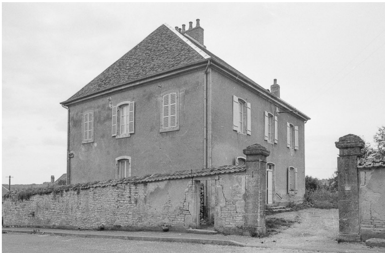
Façade sur cour.
