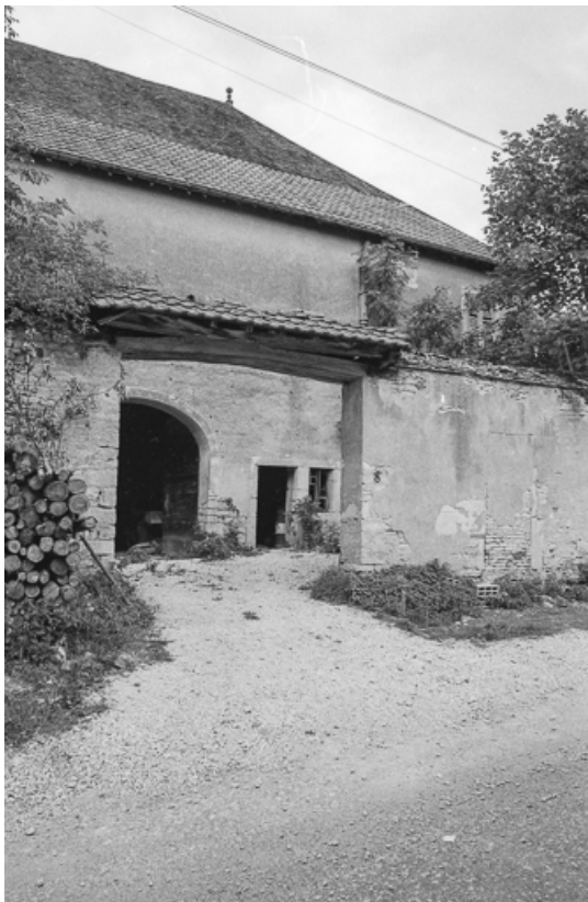
Façade latérale droite.
