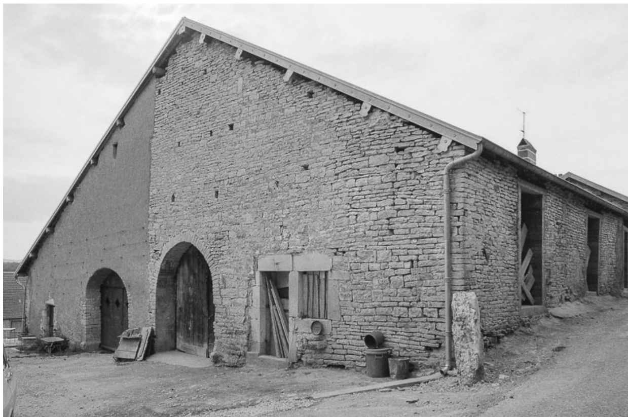
Ferme située ruelle des Voeux : façade antérieure.
