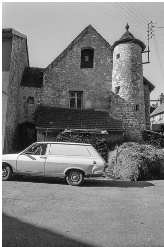
Façade sur pignon.
