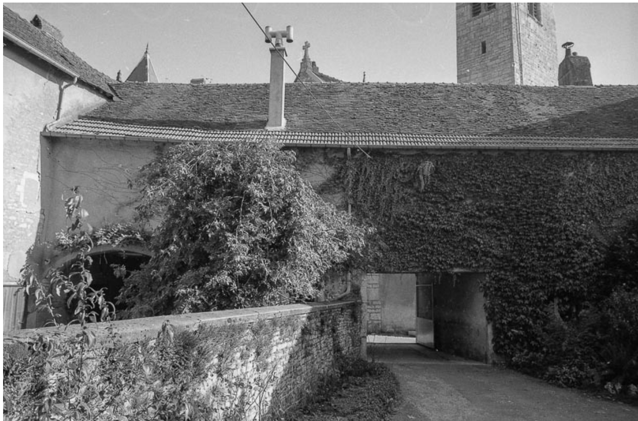
Bâtiment d'entrée : façade sur cour.
