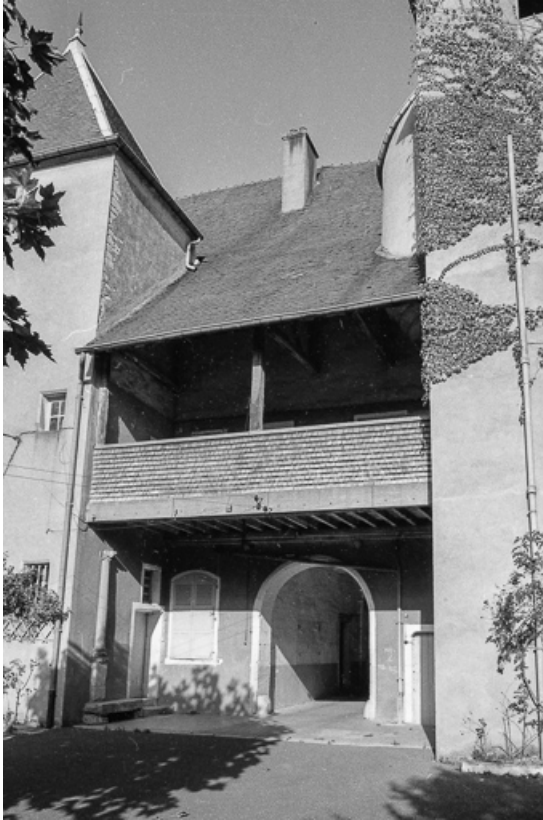
Façade sur cour.
