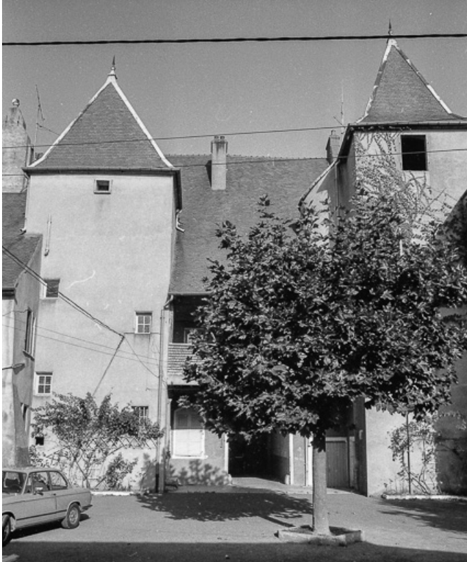
Façade sur cour.
