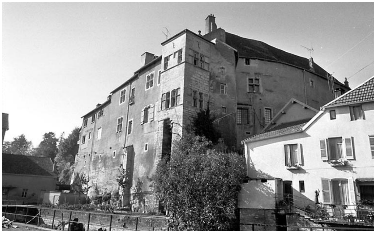
Façade est, partie droite.
