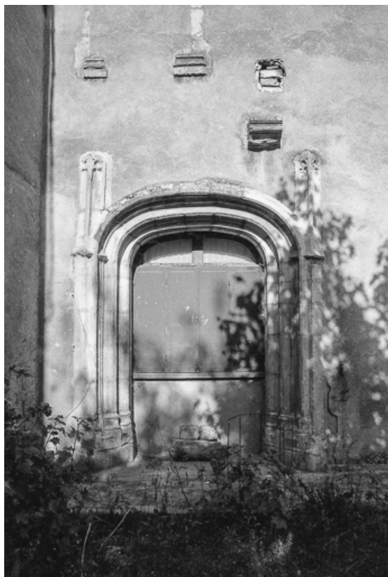
Détail d'une baie.
