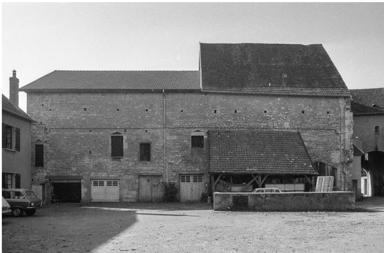
Cour : bâtiments agricoles.
