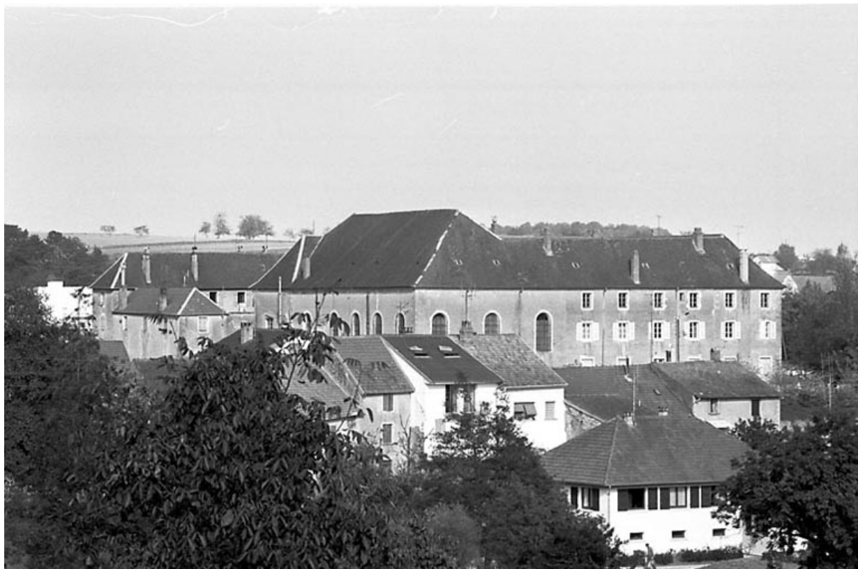
Façades sud et ouest.
