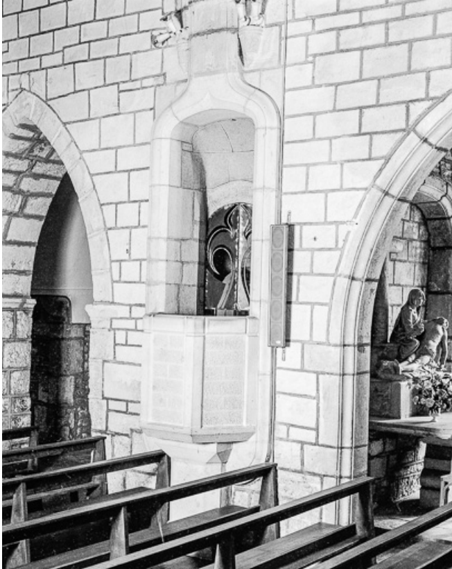
Nef : chaire à prêcher, mur droit.
