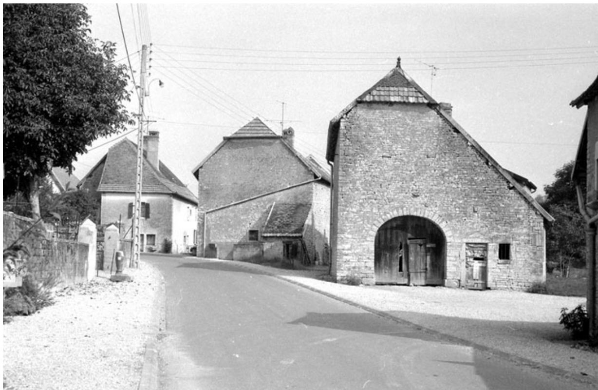
Façade latérale droite.
