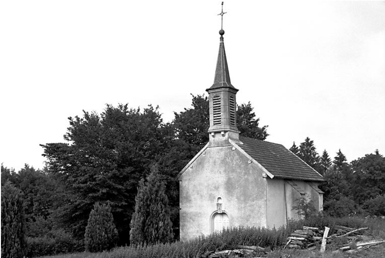
Façades antérieure et latérale droite.
