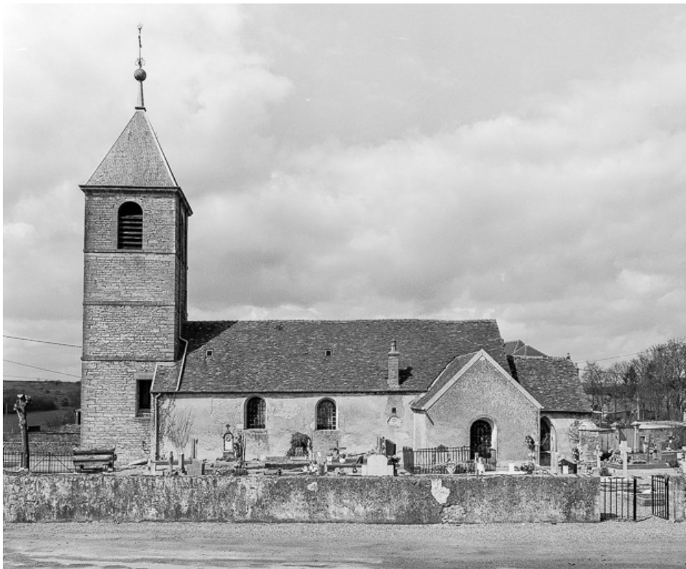
Extérieur : façade latérale droite.
