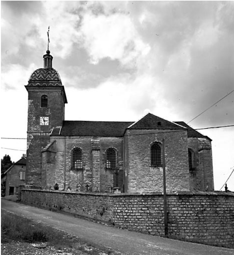
Façade latérale sud.
