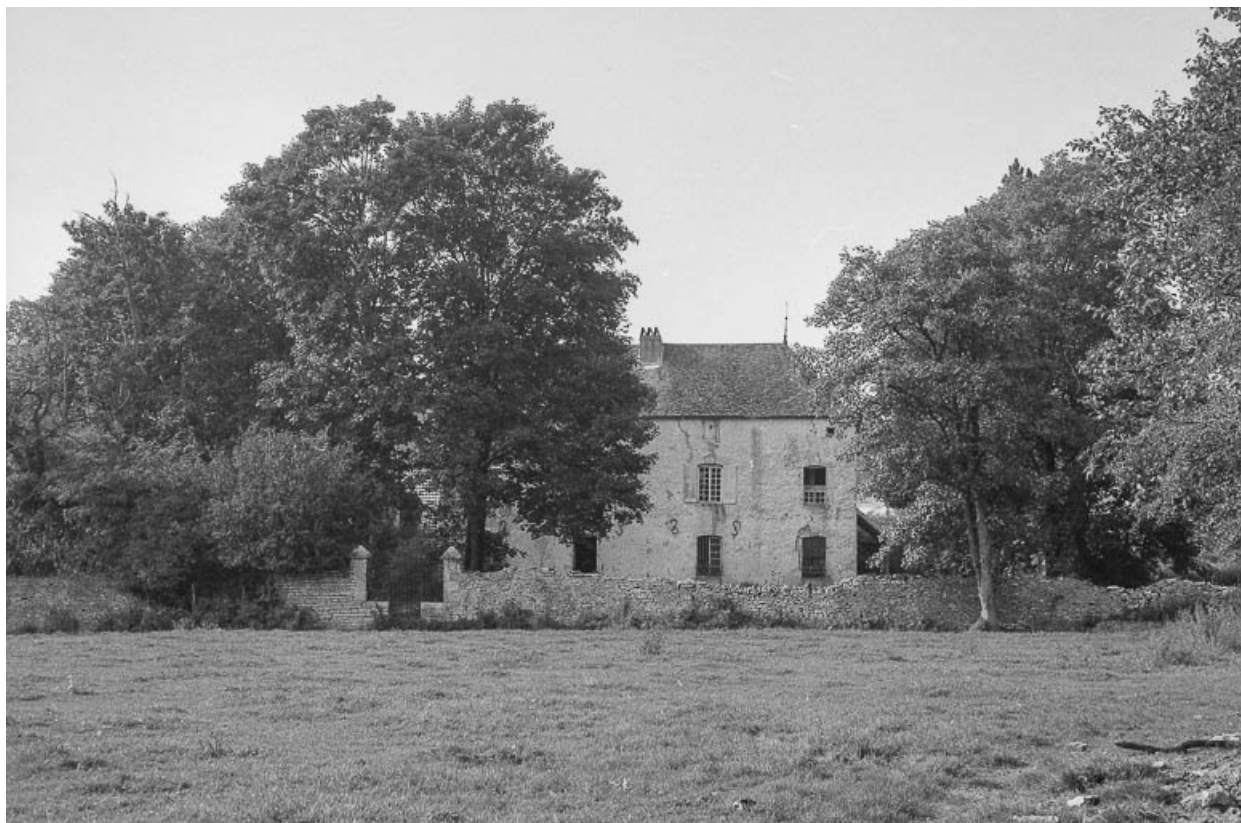
Façade sur le parc.
