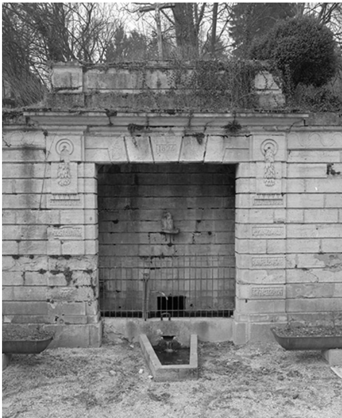
Vue de la partie centrale.
