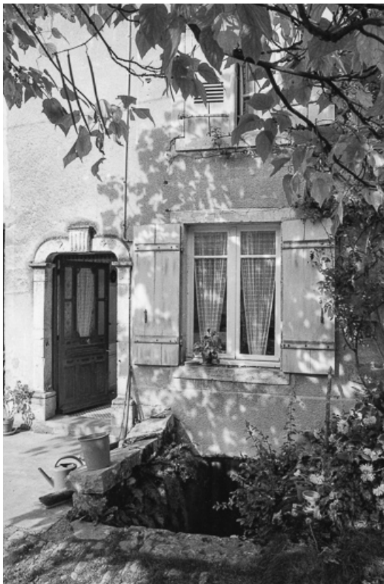
Détail : entrées de cave et d'habitation.
