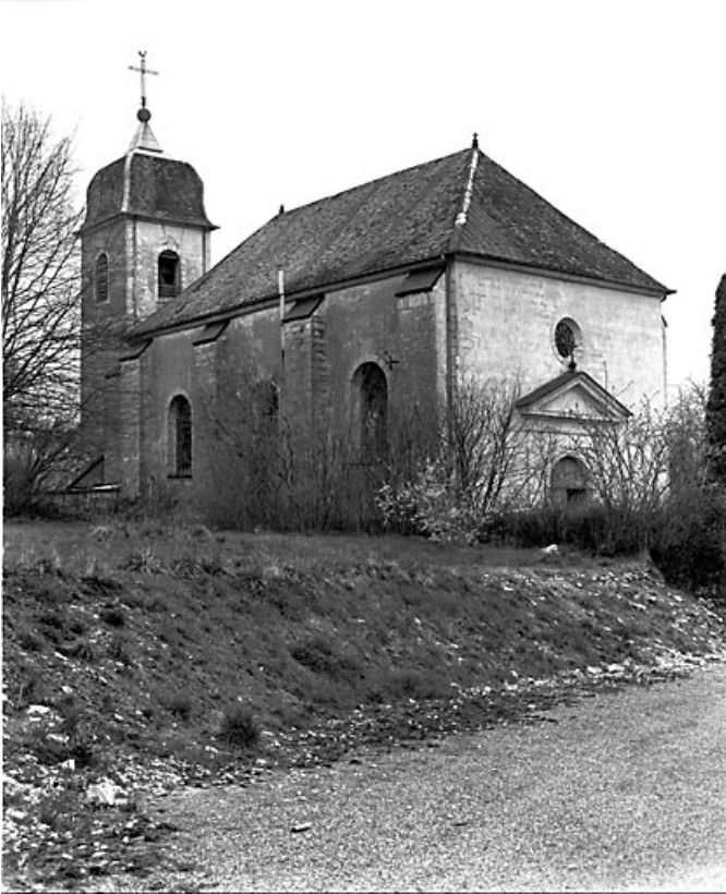
Façades antérieure et latérale gauche.
