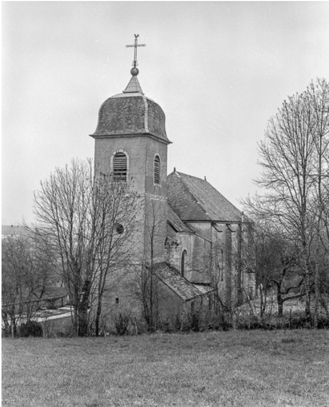
Extérieur : façades postérieure et latérale gauche.
