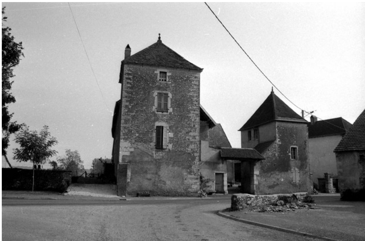
Vue d'ensemble depuis la rue d'Avrigny.
