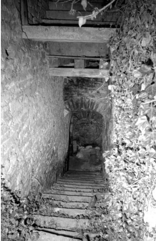
Partie habitation : escalier menant à la cave.
