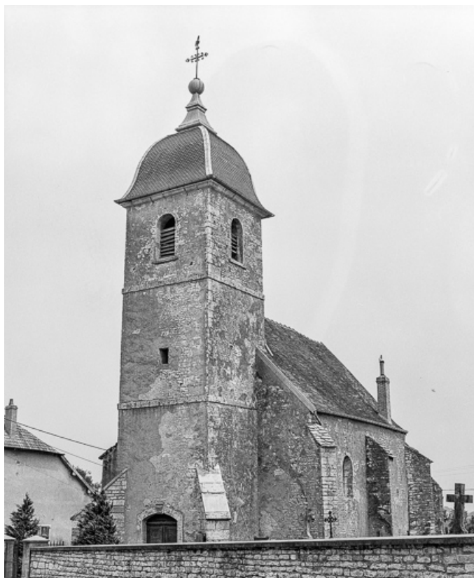
Façade antérieure et face latérale droite.
