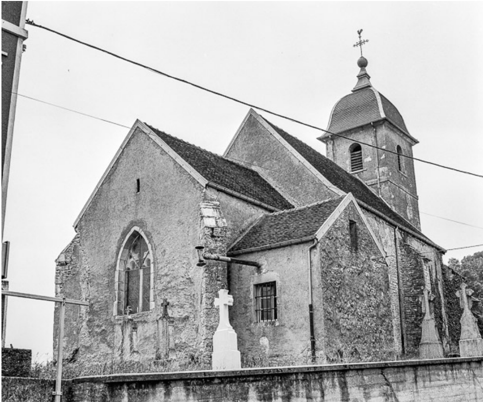
Façades postérieure et latérale gauche.
