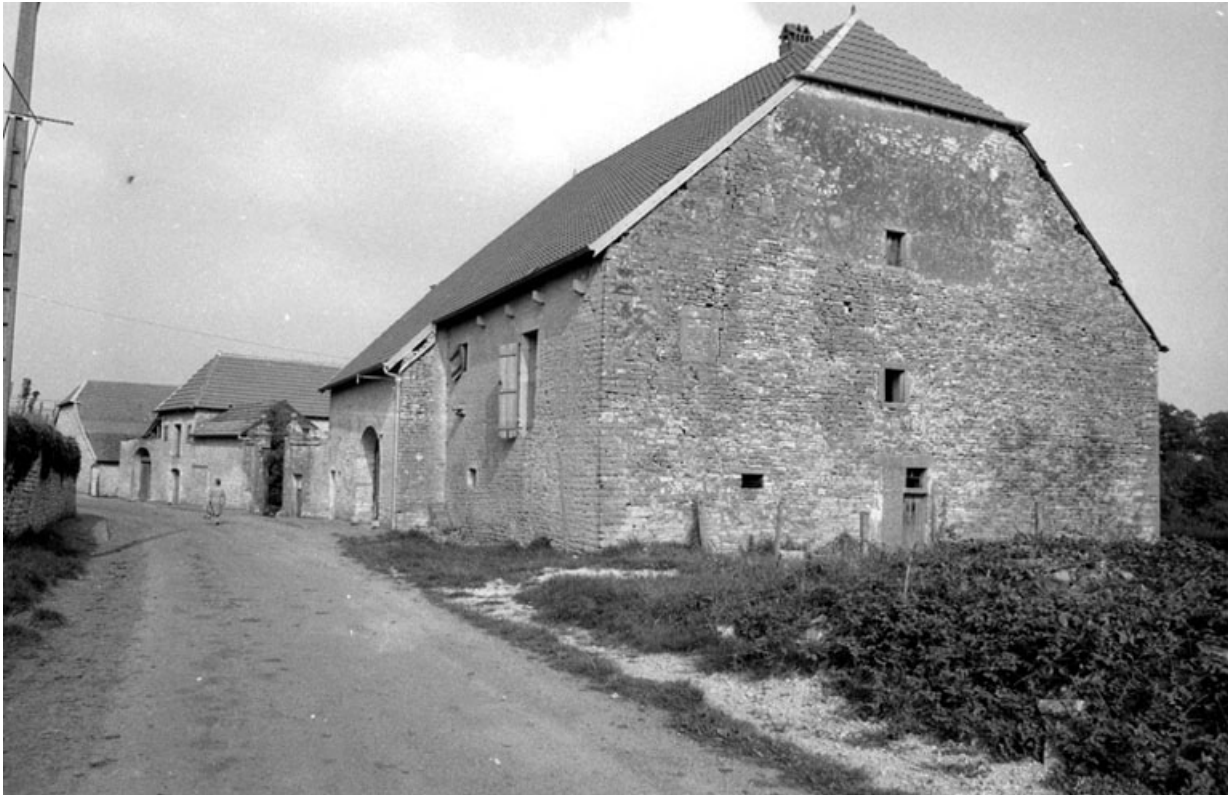
Façade antérieure et latérale droite.
