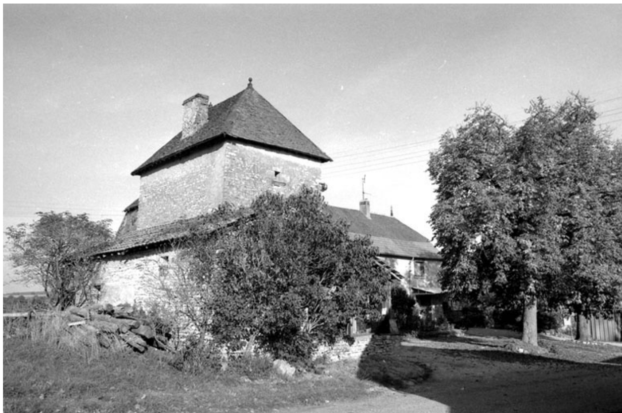
Partie habitation : face latérale gauche.
