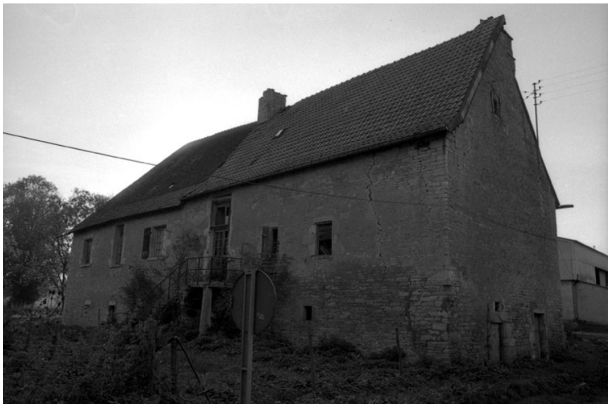
Partie agricole : façade postérieure.
