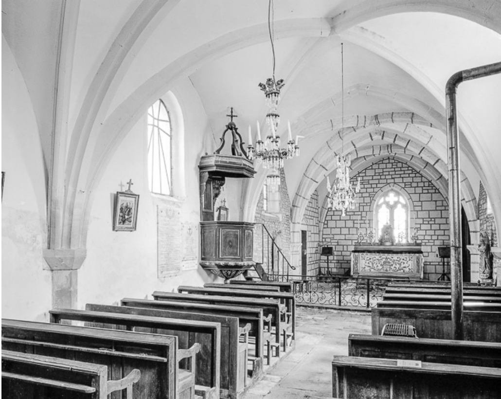
Vue de la nef et du chœur.
