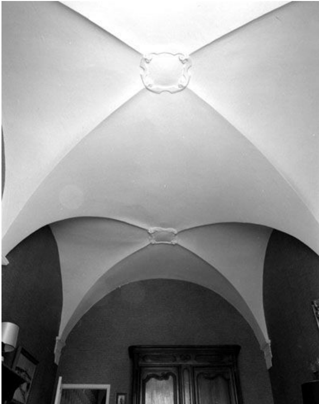
La voûte de la chapelle.
