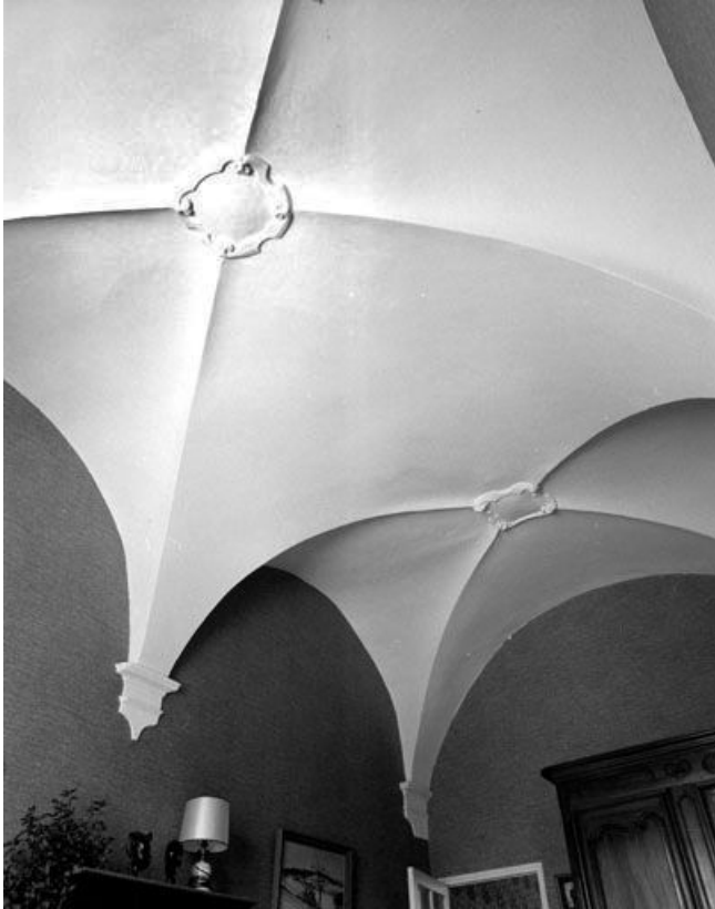
La voûte de la chapelle.
