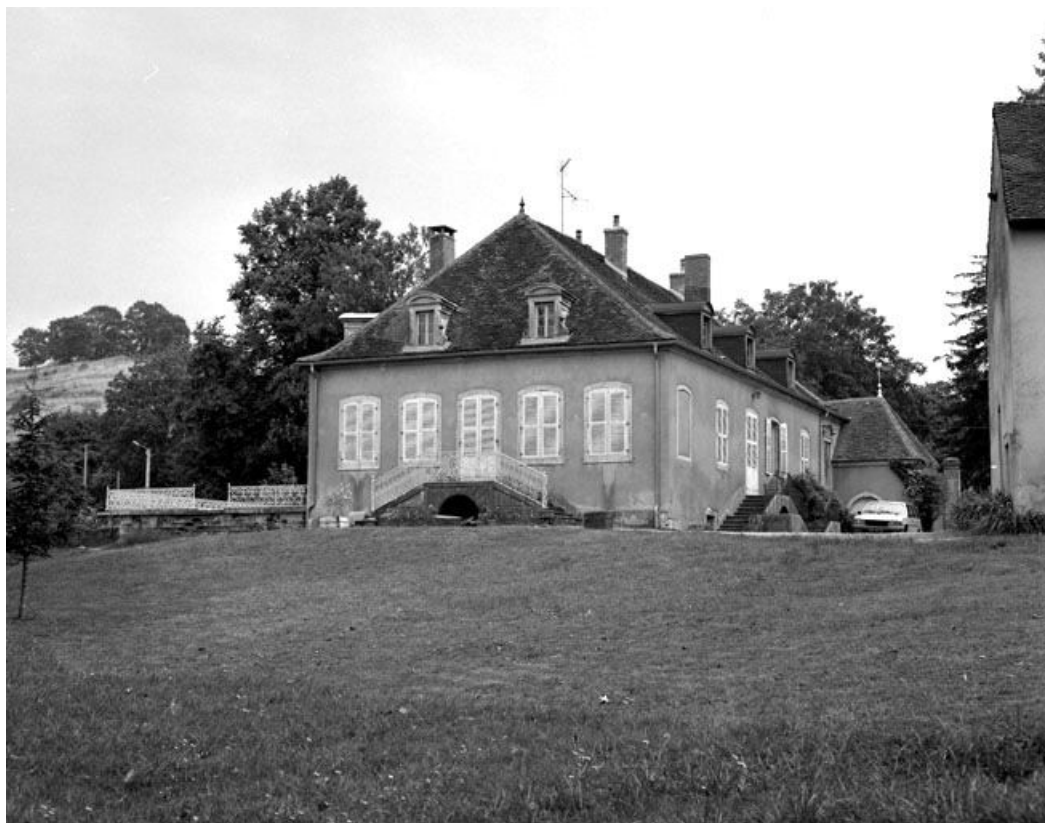
Façade droite du logis.
