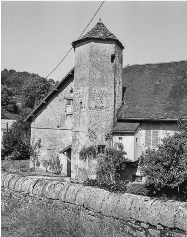
Vue du muret et de la tour.
